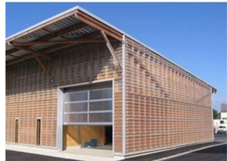
Parc d'exploitation du service gestion des déchets de la Carene Saint Nazaire (44)
