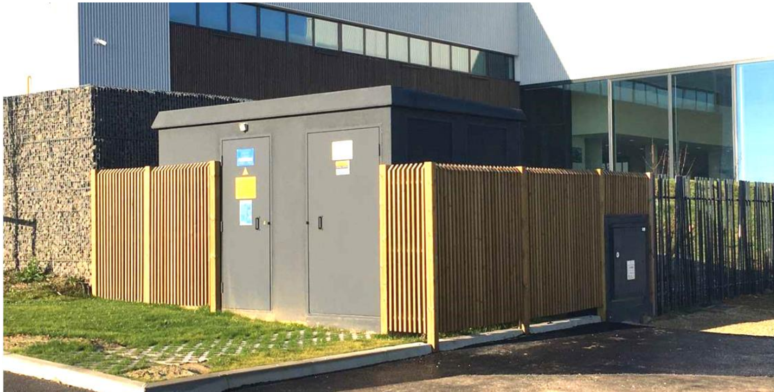
Poste de Distribution Publique et coffrets intégrés au bardage bois
