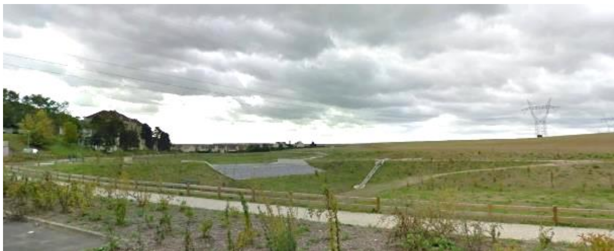
Figure 19 : Bassins de rétention du Coudray
