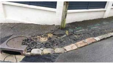
Travaux effectués par le service technique communal, sur un trottoir abîmé par le passage d'un poids lourd non identifié, à l'angle des rues des Pinsons et des Alouettes.
