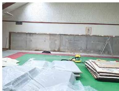
Reprise des cloisons des murs en périphérie intérieure du dojo Judo dans le cadre d'une solidification des cloisons abîmées suite à des chocs latéraux. Recherche et réparations des infiltrations d'eaux au niveau de ces cloisons (4 points d'infiltration d'eaux ont été trouvés). Ces travaux ont été réalisés en interne.
