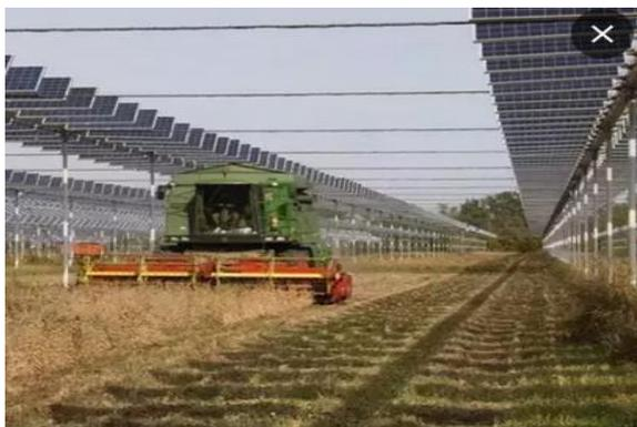
L'agri voltaïque (agrivoltaïsme ou agri-photovoltaïsme) est un système étagé qui associe une production d'électricité photovoltaïque et une production agricole au-dessous de cette même surface.
