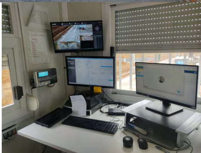
Installations d'accueil Pont-bascule / Base-vie
